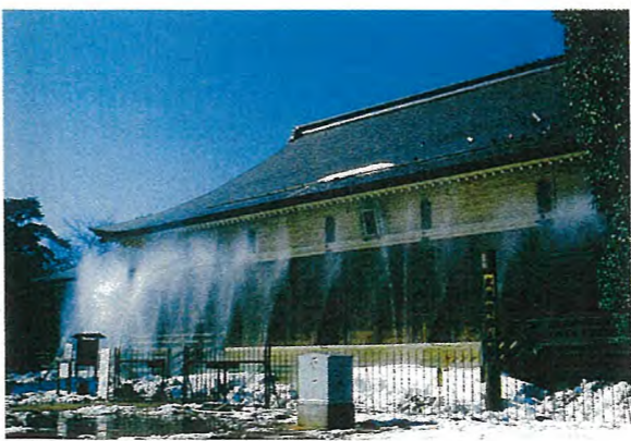
スプレーノズルによる水膜(武蔵野野郷土館)スプレーノズル(水膜用、ジェットノズル破風用、ドレンチャー)ノズル(回転高所破風用)の三種。
