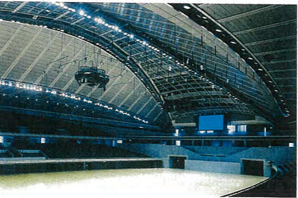
音場支援システム(東京体育館)D値とは50ミリ秒以内で到達した直接音の成分が、間接音を含めた全成分の中に示す割合を示す室の響き、明瞭度に関する量の値。
